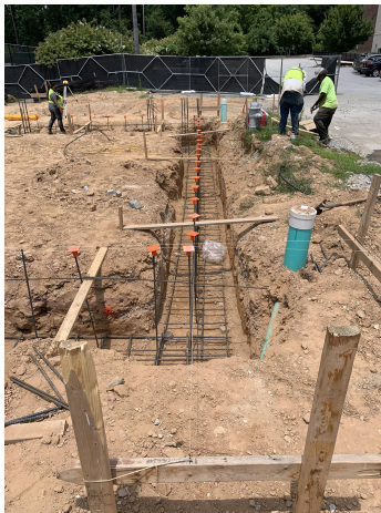
CSK- Concession concrete pour prep
